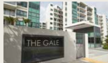
The Gale • Flora Road • 329 Units • TOP: 3 Jan 2013
